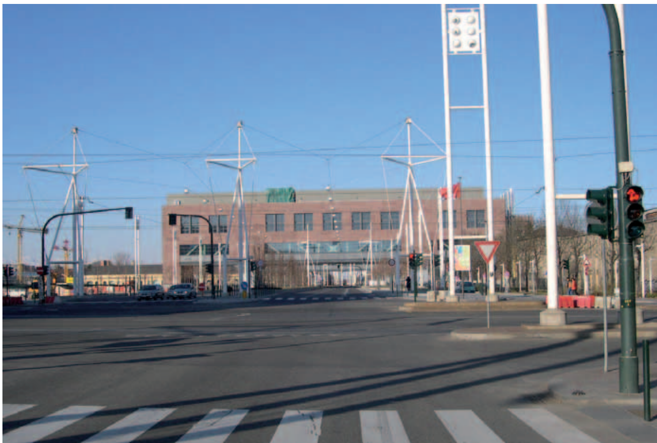
Figura 3. Il raddoppio del Politecnico sul viale della Spina. Figure 3. The Polytechnic redoubling on the Spina boulevard.
